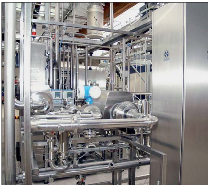
Die Beruhigung von bis zu 10000 l Getränk schafft jeder der beiden Cavitatoren in der Stunde.
